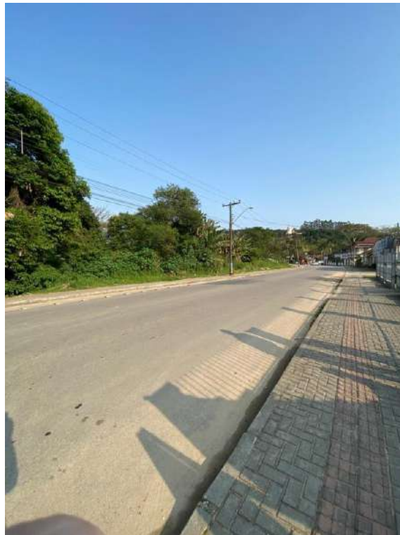
Foto 15- Frente do Terreno.
