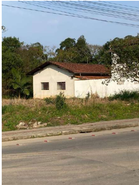
Foto 07- Frente do terreno.
