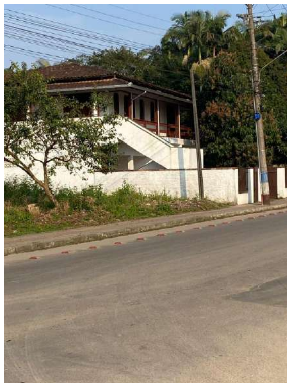
Foto 08- Frente do terreno.
