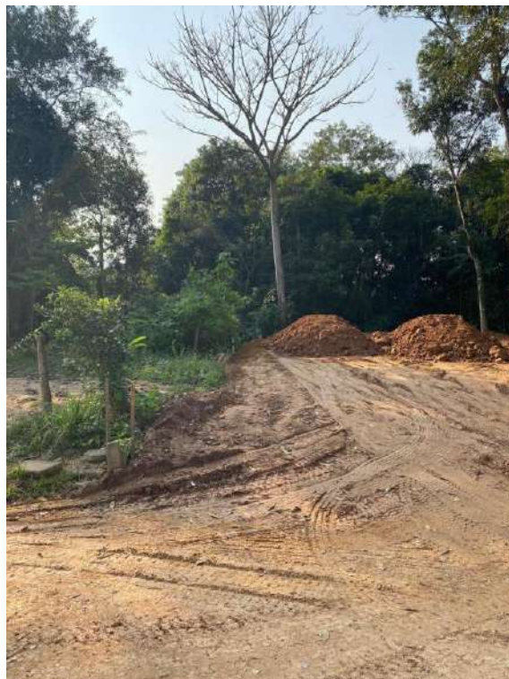
Foto 23 – Aterro sendo realizado.
