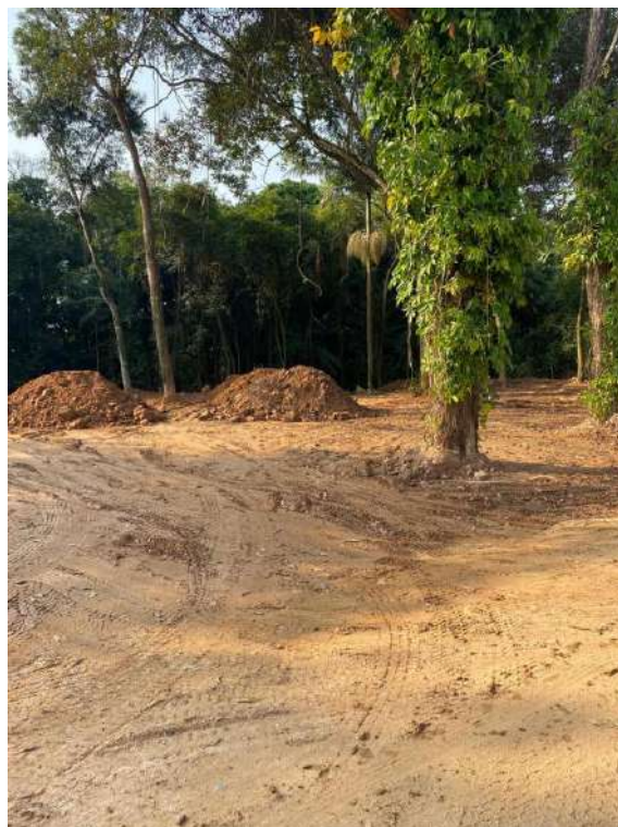
Foto 22- Aterro sendo realizado.
